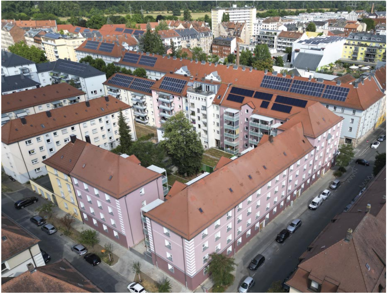
Bild: WIE 02 nach Modernisierung
